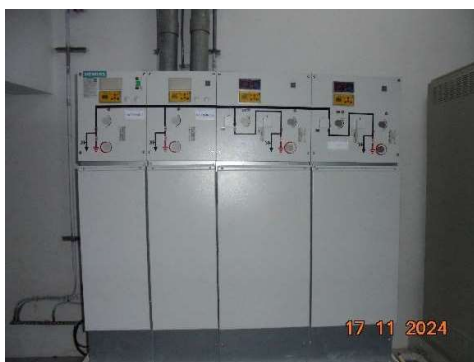
ตู้ไฟฟ้าแรงสูง (RMU)
