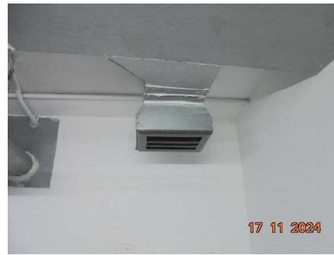
ระบบระบายอากาศห้องพักขยะมูลฝอยรวม
